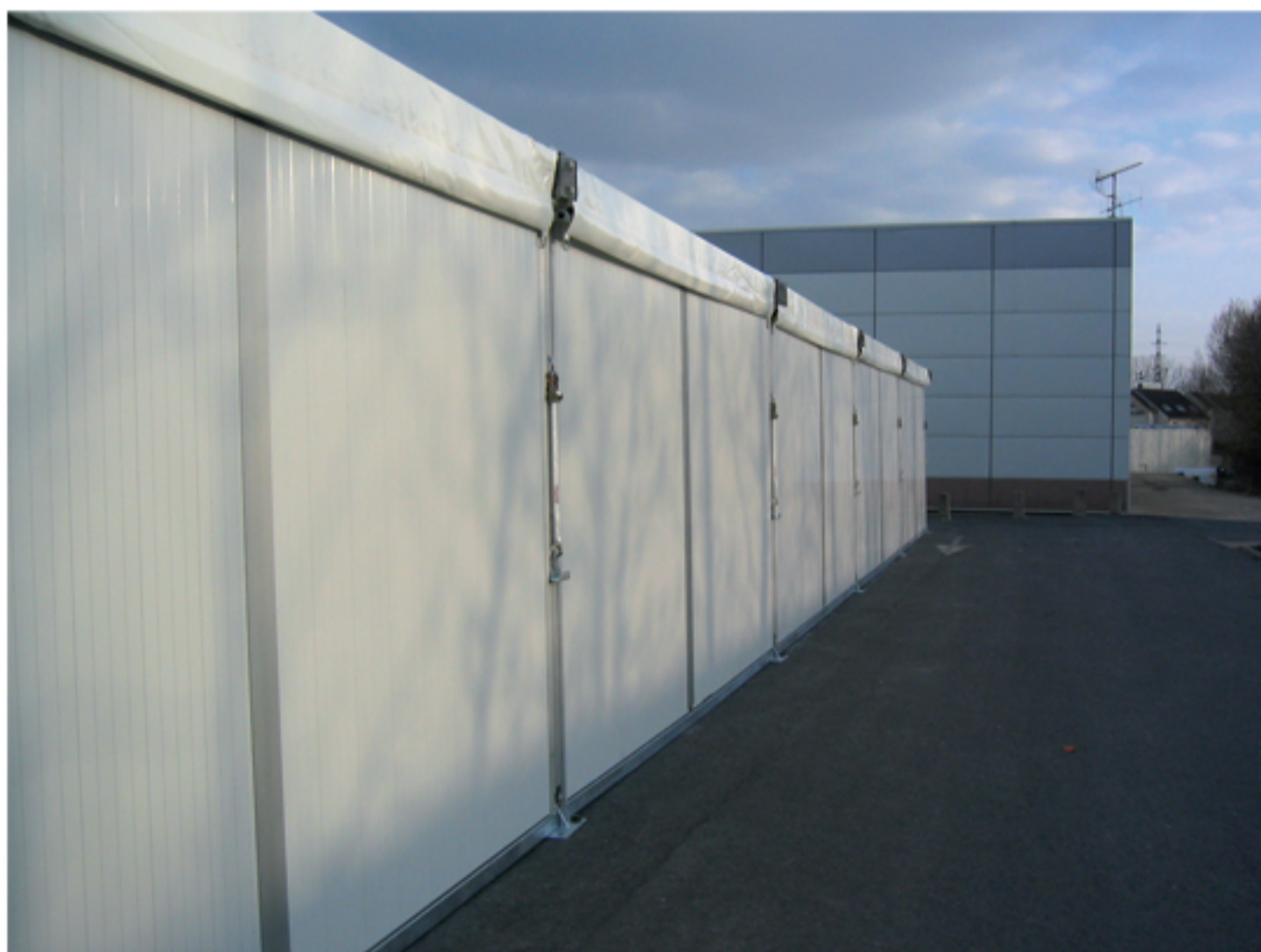
Murs externes en parois rigide PVC blanc.
