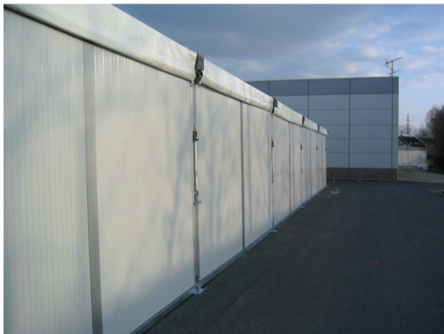
Murs externes en parois rigide PVC blanc.
